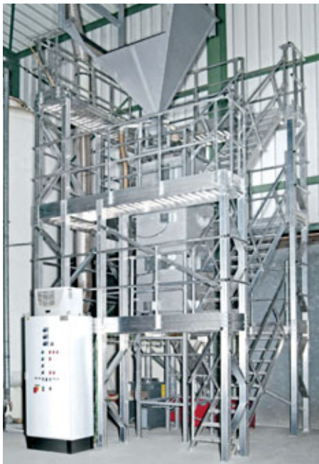
Zuverlässige Einrüstungen ermöglichen den sicheren Zugang zu unwegsamen Anlagen
